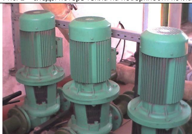
Рис. 4 – нагрев сетевого насоса в пределах нормы.
