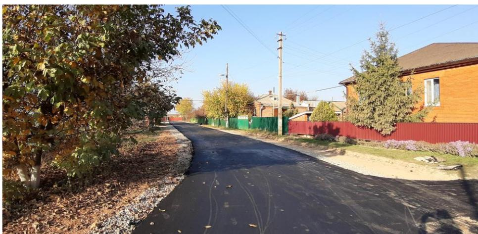
В ходе ремонтных работ было произведено восстановление поперечного профиля основания дороги с учетом отвода дождевых вод, произведена укладка асфальтобетонного покрытия с щебеночным основанием. Ремонт этого участка дороги площадью более 2175 кв.м
